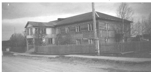
На фото: Контора «Лескора» (не сохранилась).
